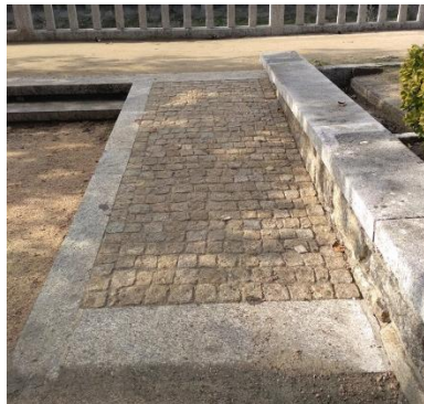
Imaxe 1: Rampla construída na última reforma da Alameda
